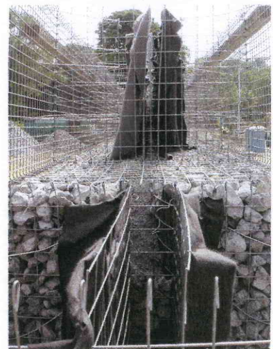
Abbildung 3: Gabione als Lärmschutzwand, SpA Kikweg in Düsseldorf Bild: pslandschaft.de
