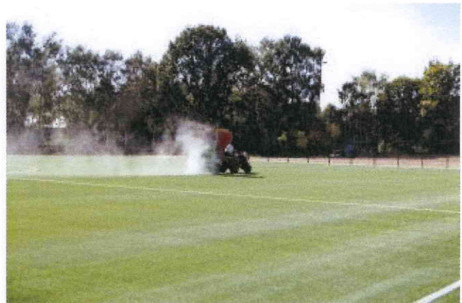
Abbildung 13: Besanden eines Kunstrasenplatzes Bild: pslandschaft.de
