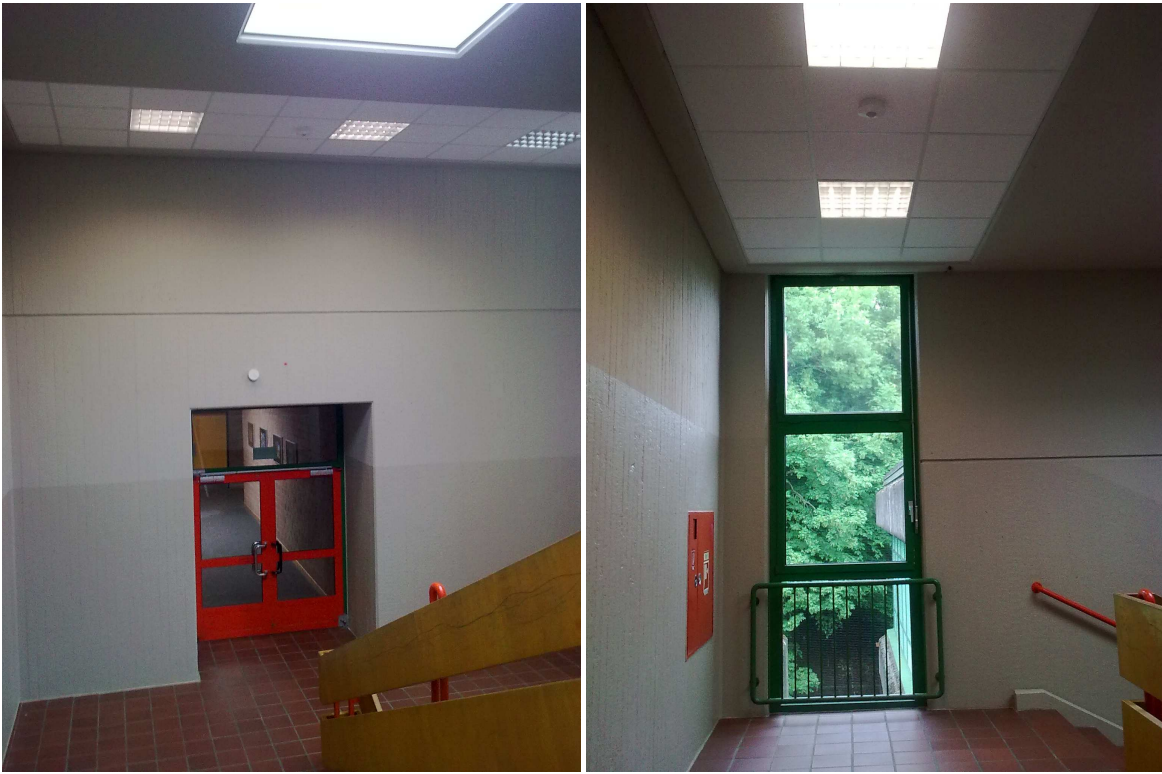
Die Fotos zeigen die sanierten Treppenhäuser.
