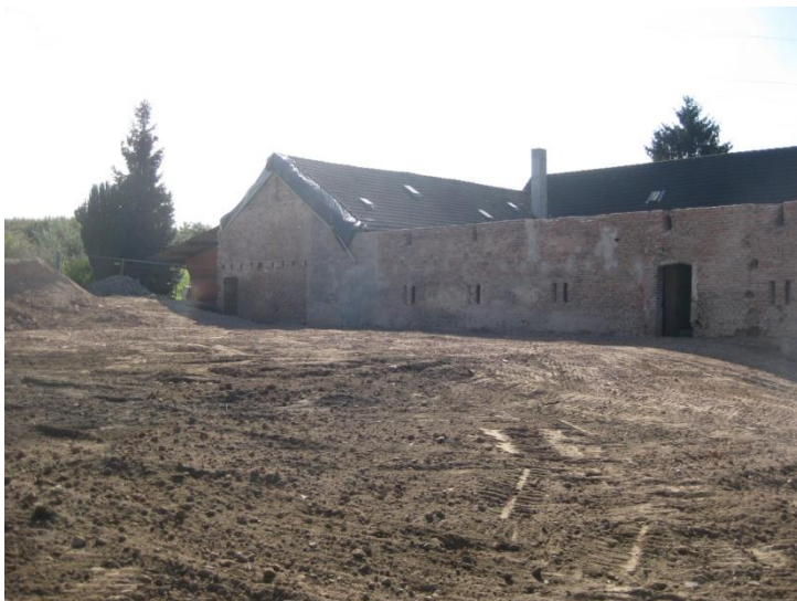
Baufeld nach Abbruch der Scheune
