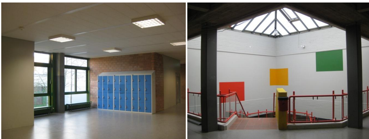
Brandschutzsanierung Flure und Treppenhäuser
