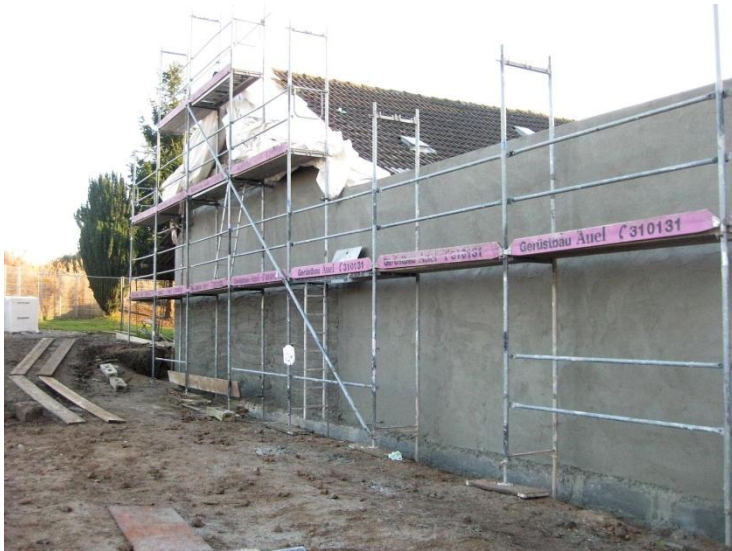
Ertüchtigung der Nachbarwand
