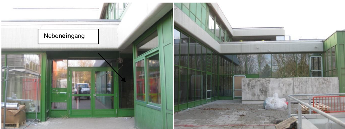
Haupteingang Schulzentrum Wiesengrundstraße und Außenterrasse Mensa (ehem. Nebeneingang)
