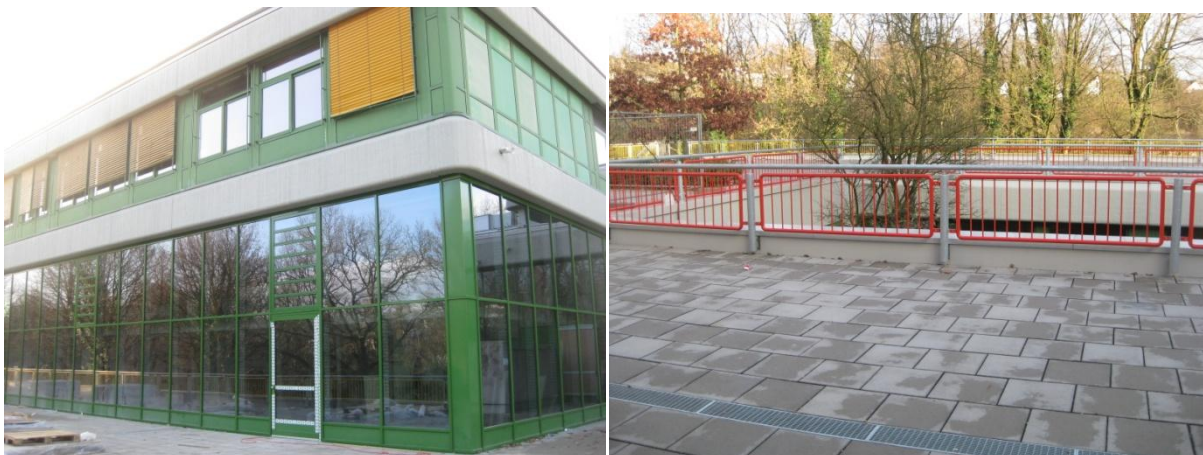
Neubau Mensa und Dachsanierung Schulhof über 2.UG
