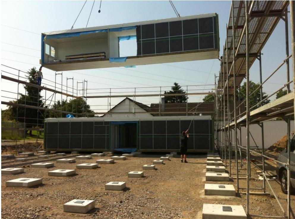
Aufstellung der Container-Module des EG in Gebäudebreite auf Bodenverbesserungsschicht mit Fundamenten
