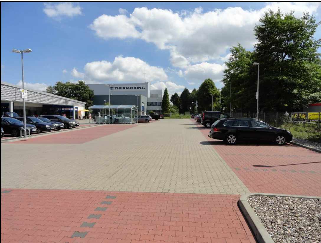
Abb. 5: südlicher Parkplatzbereich angrenzend zur Landstraße
