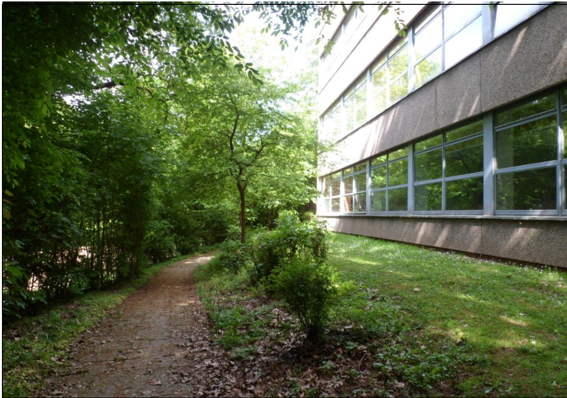
Abb. 5: Bereich zwischen der Nordseite des Schulgebäudes und dem Fahrweg „Horstmannsmühle“ (hier nicht zu sehen) © IVÖR
