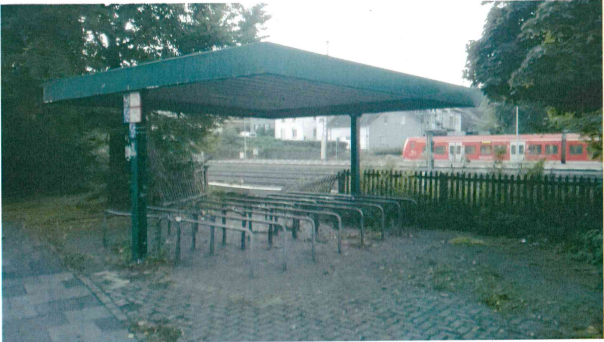
Bahnhof Gruiten – rückwärtig gelegene Witterungsschutzeinheit
