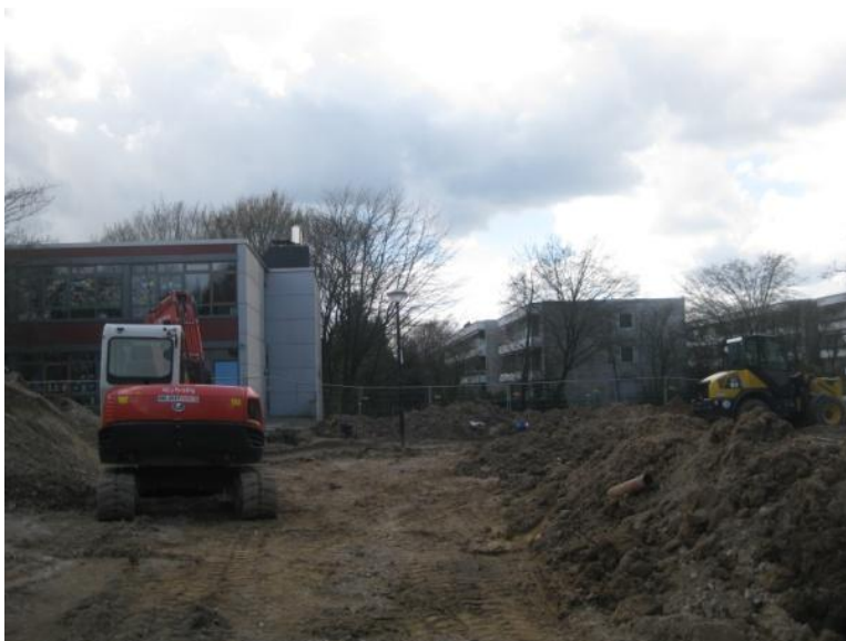
Baufeld im Bereich der abgebrochenen Pavillons
