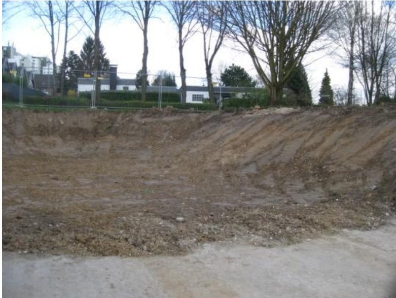
Baufeld im Bereich des abgebrochenen Hausmeisterhauses
