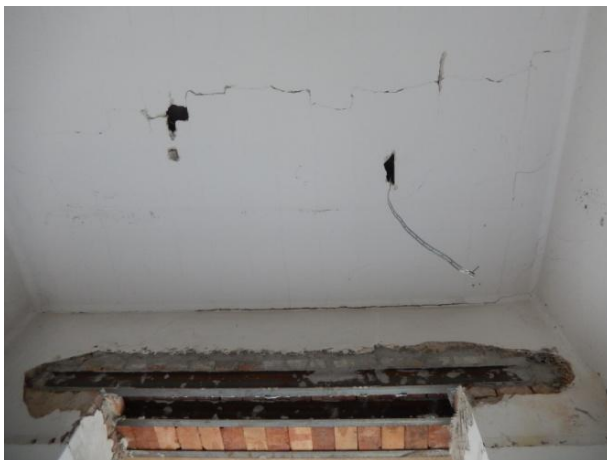
Zustand der Rohdecken
