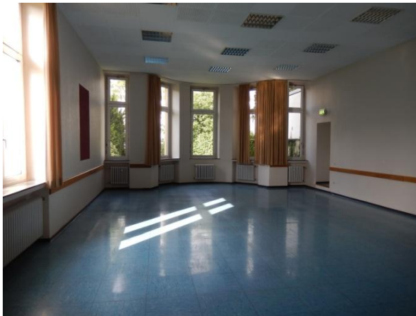
Speisesaal EG vor Umbau
