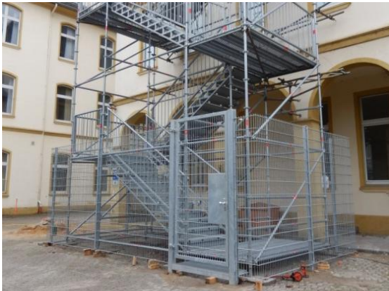
gesicherter Nottreppenturm
