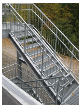
Fluchttreppe R II
