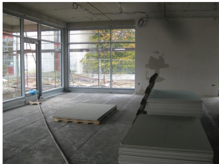
OGS – Mensa im Rohbau
