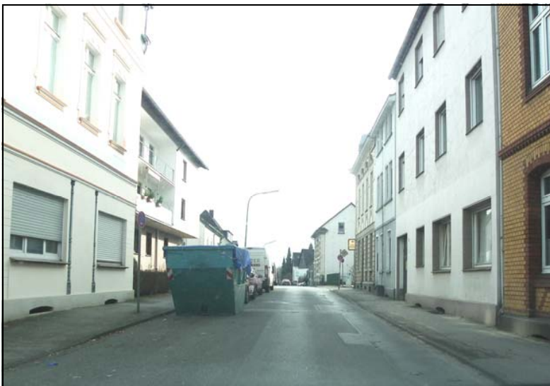
Bild 10: Foto Turnstraße (Blick nach Süden)
