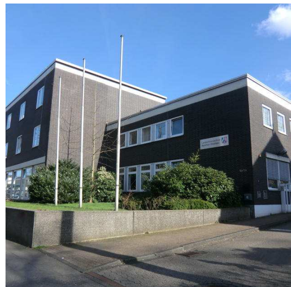
Abb. 24: ehem. Landesfinanzschule in der Kaiserstraße
