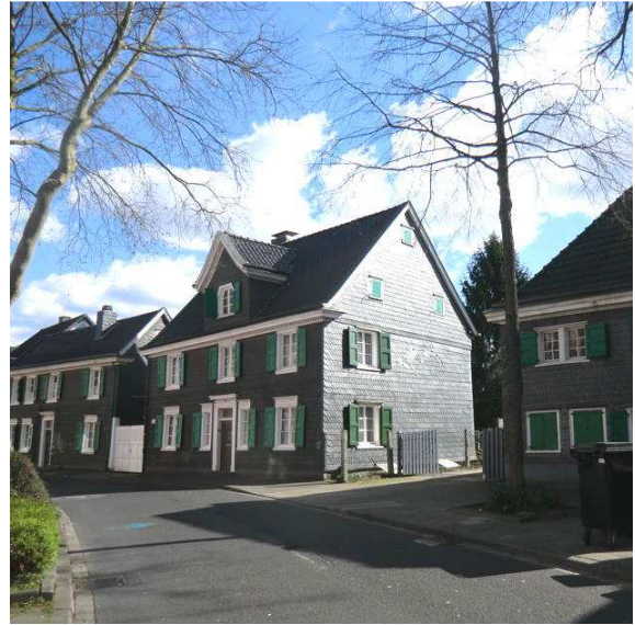
Abb. 8: Schiefergebäude in der Walder Straße
