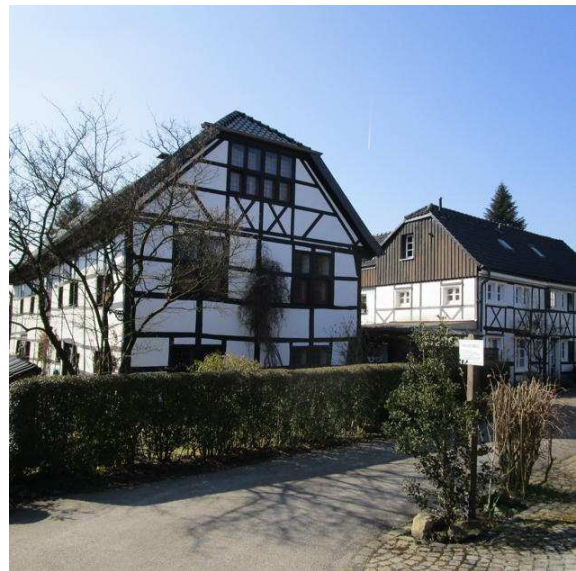
Abb. 6: Fachwerkhäuser im Bereich »Horst«
