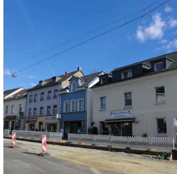
Abb. 45: Dachlandschaft entlang der Bahnhofstraße
