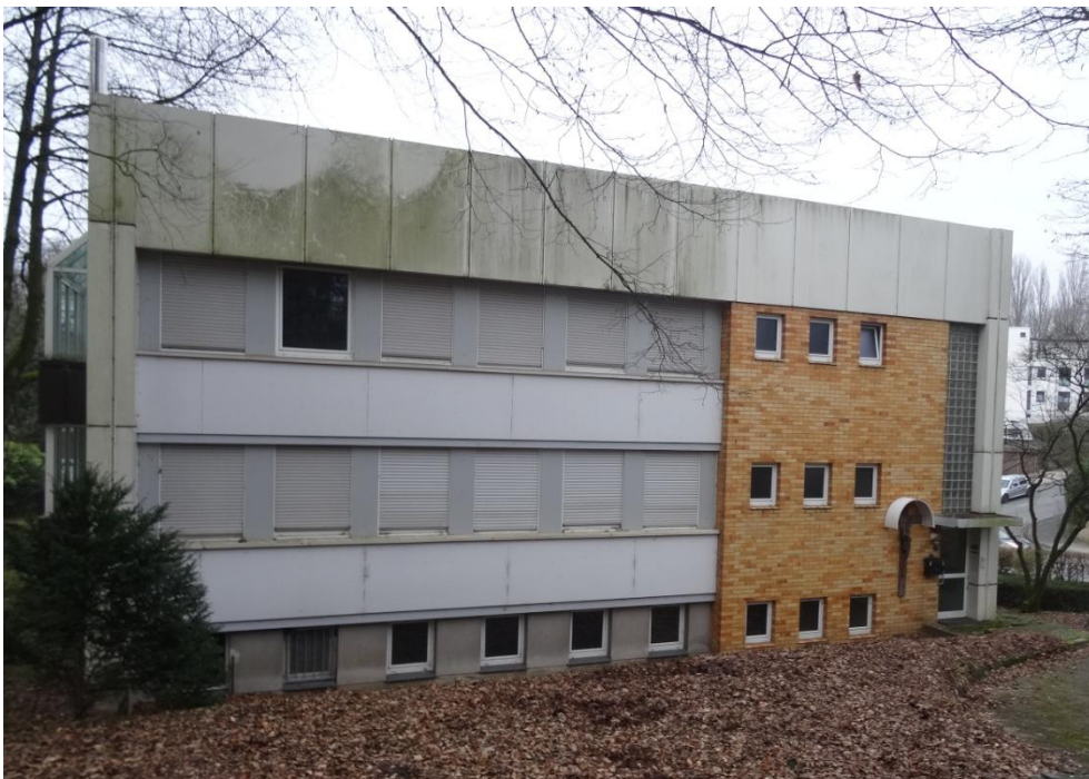
Abbildung 4: Fassadenansicht des abgehenden Gebäudes
