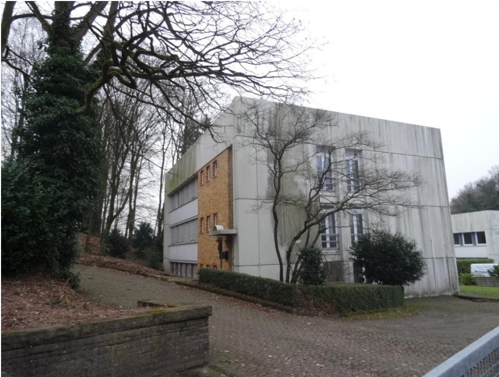
Abbildung 3: Blick auf das abgehende Bestandsgebäude von der Robert-Koch-Straße
