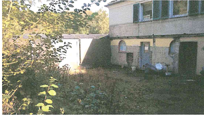
Zustand Eingangsbereich Tierheim Velbert
