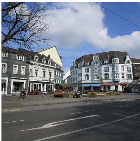
Abb. 44: Dachlandschaft im Ortszentrum
