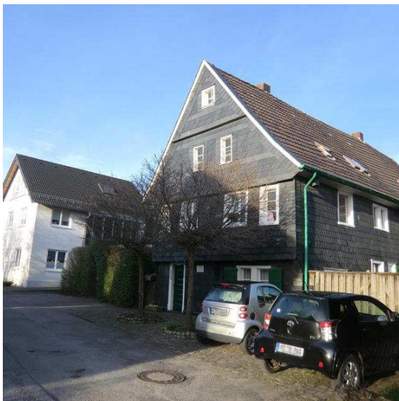
Abb. 38: Weilerartige Bebauung im Bereich »Stöcken«
