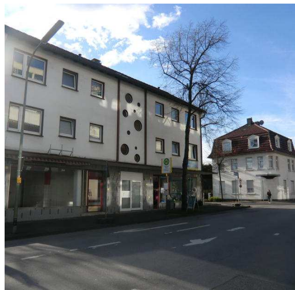
Abb. 14: Wohn-/Geschäftshaus in der Schillerstraße
