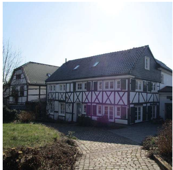
Abb. 39: Weilerartige Bebauung im Bereich »Horst«
