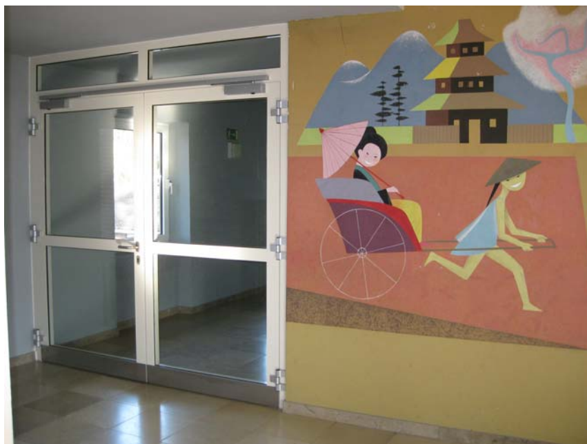
Neue Rauchschutztüren im OG der Don-Bosco-Schule
