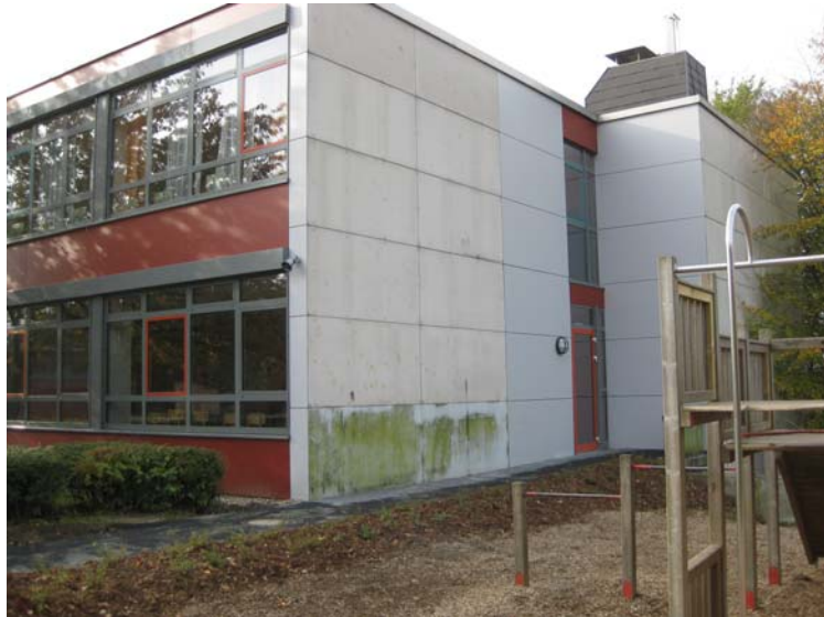
teilsanierte rückwärtige Fassade
