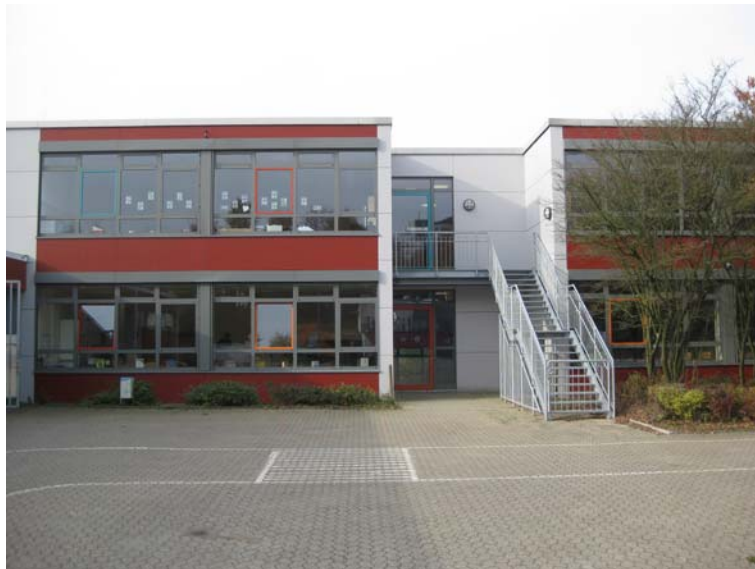
schulhofseitig erstellter 2. Rettungsweg
