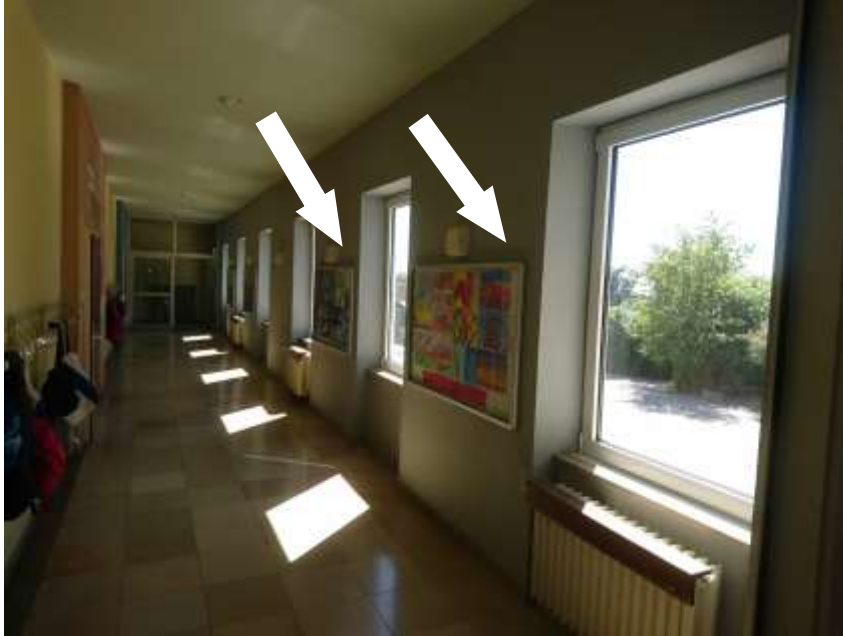
Probenahmen von Feinputz auf Wandflächen, Anbau neuer Beleuchtungen im Bereich der Flure
