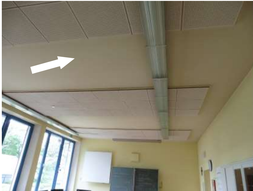
Probenahme von auf Deckenflächen in Klassenräumen, Einbau neuer Abhängedecken
