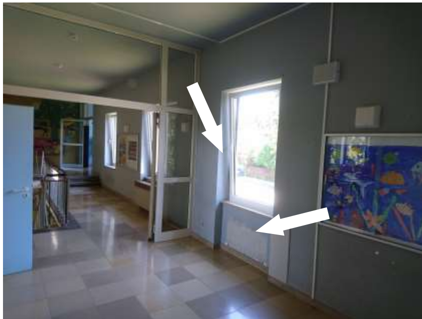
Probenahmen von Feinputz in Heizkörpernischen und Fensterleibungen, Herstellung von Wandöffnungen für neue Fluchtwegausgänge
