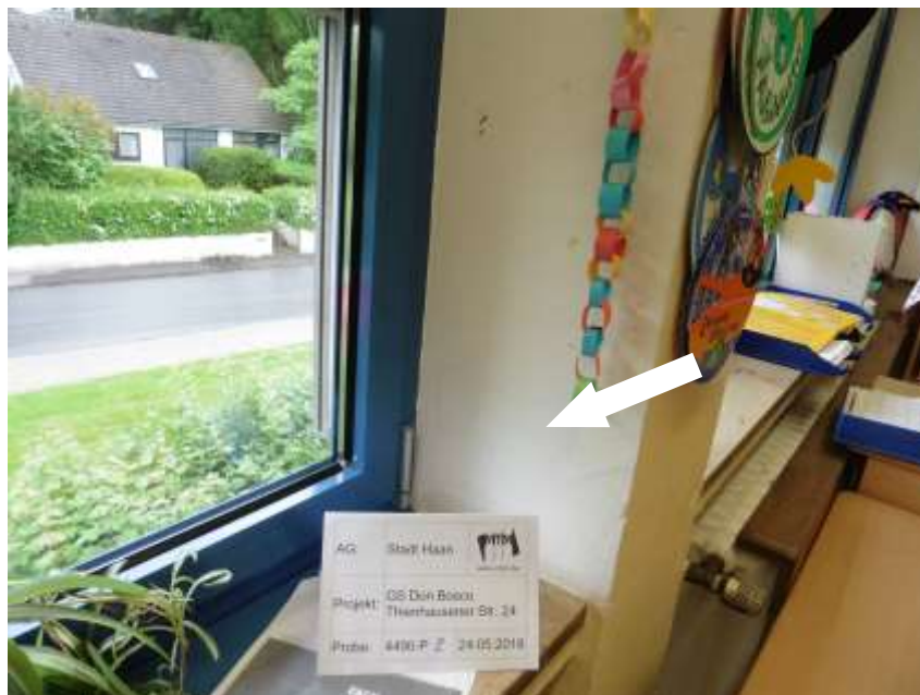
Probe-Nr. 4490-P2 Feinputz, Fensterleibung diverse Räume, OG
