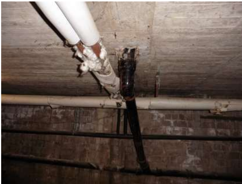
Künstliche Mineralfasern als Isolierung der technischen Gebäudeausrüstung; UG, Turnhalle
