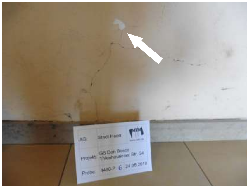
Probe-Nr. 4490-P6 Farbanstrich hellorange, Massivwand, Flur, OG
