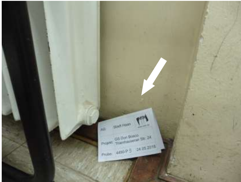
Probe-Nr. 4490-P3 Feinputz, Heizkörpernischen, diverse Räume, OG
