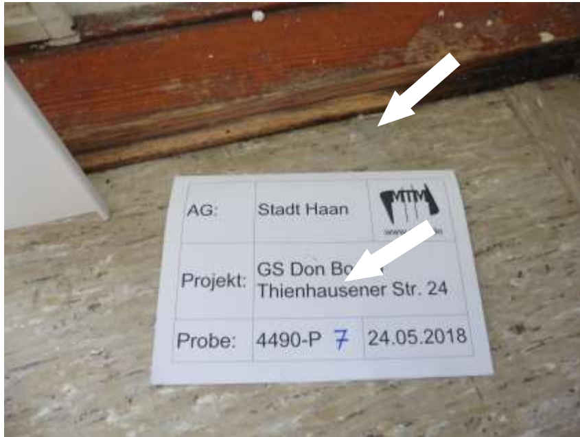
Probe-Nr. 4490-P7 Ausgleichmasse Kleber, unter PVC-Bodenbelag, Raum 102, OG
