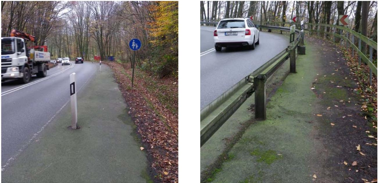
**Bild 5-9:** Bestand Ittertalstraße, Gehweg auf Seitenstreifen und hinter der Leitplanke
