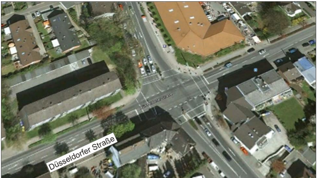
Abbildung 3: Knotenpunkt Düsseldorfer Straße (B 228) / Hochdahler Straße [Quelle: Google Earth Pro]
