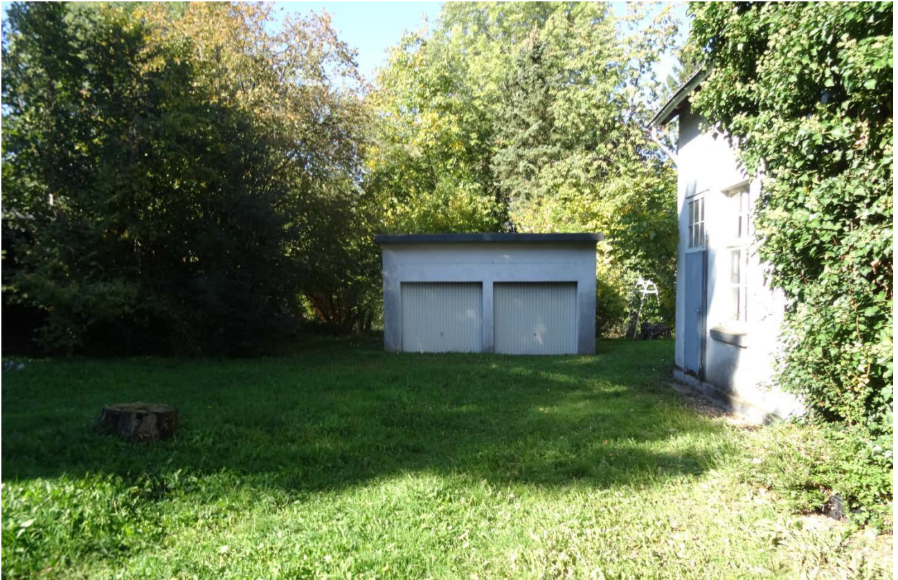
Abb. 4: Doppelgarage im zentralen Plangebiet mit nördlichem Wohngebäude (ISR, 2018)
