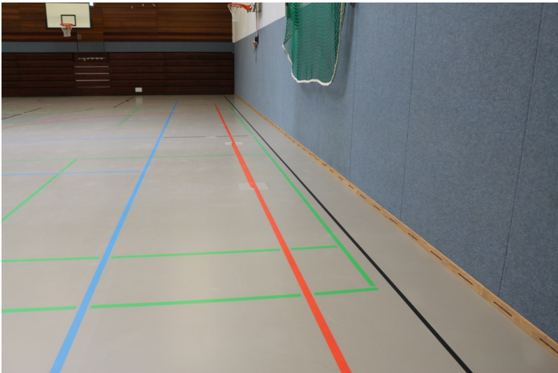
Bild 7: Hochkant-Sockelleiste vor der Prallwand
