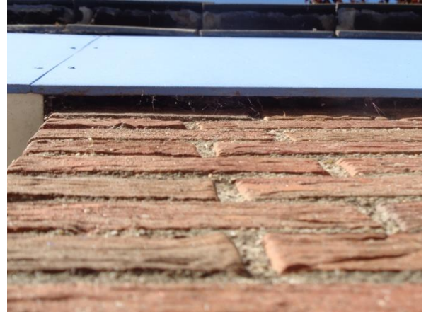
Abbildung 4: Gemeindehaus mit kontrollierter Plattenverkleidungen an der Außenwand unterhalb des Daches
