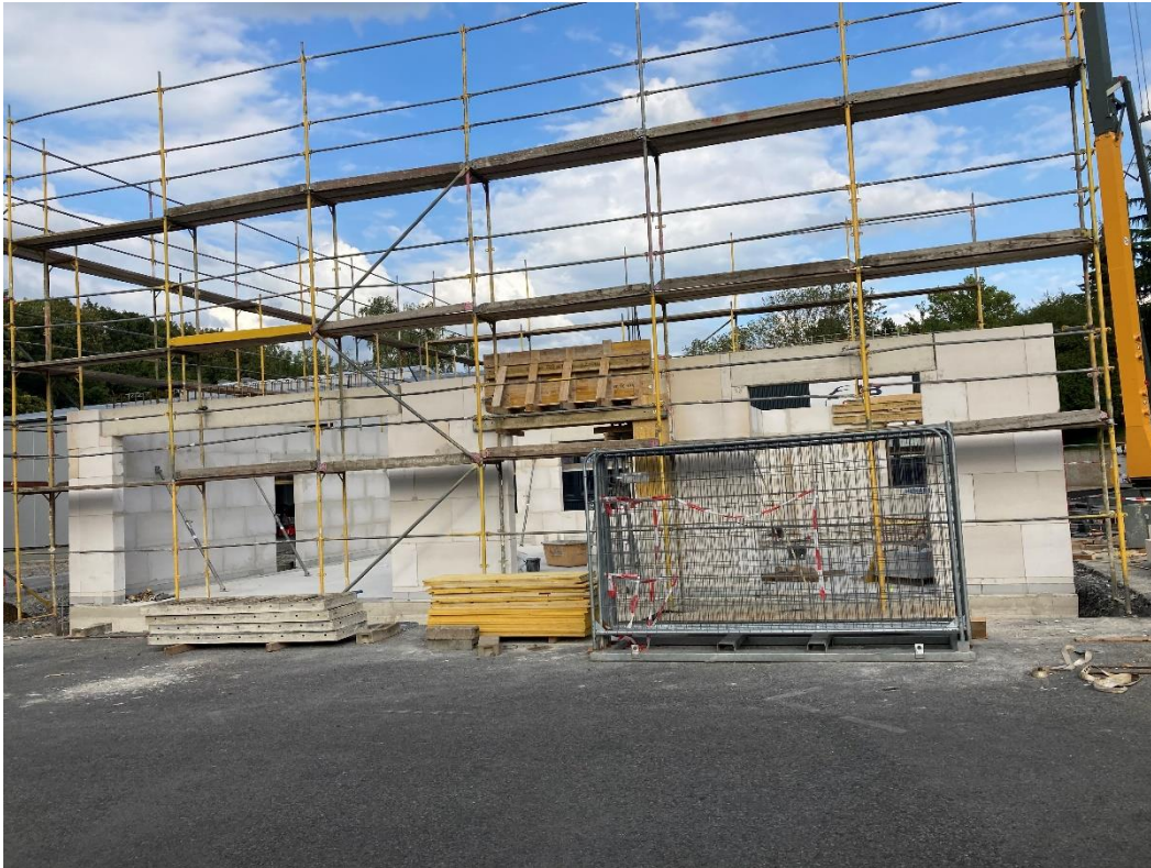
Abb. Baustelle Neubau / Anbau JB CarConcept GmbH
