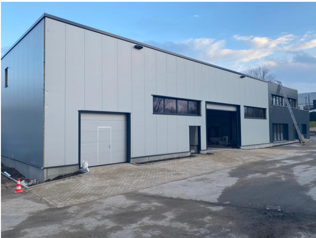
Abb. Baustelle Neubau / Anbau JB CarConcept GmbH (Foto JB CarConcept)
