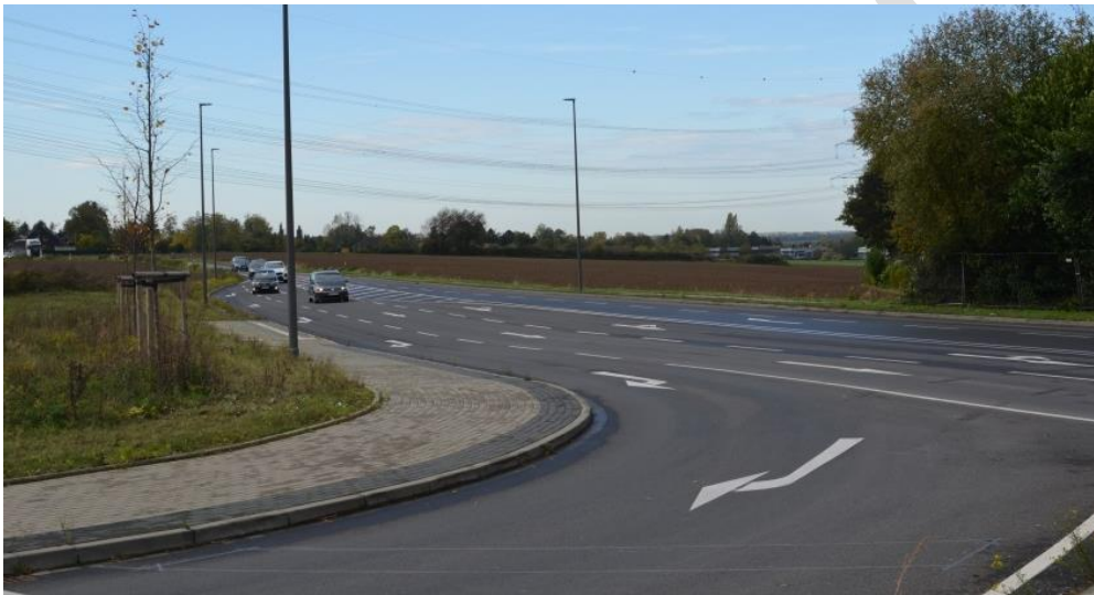
Abb. 5.4.1-1 „Polnische Mütze“ in Fahrtrichtung Gruitener Straße (Quelle: Eigene Aufnahme)
