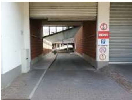
Tiefgarage: Dieker Straße - Einfahrt
