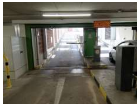
Tiefgarage: Dieker Straße – Ein-/Ausfahrt
