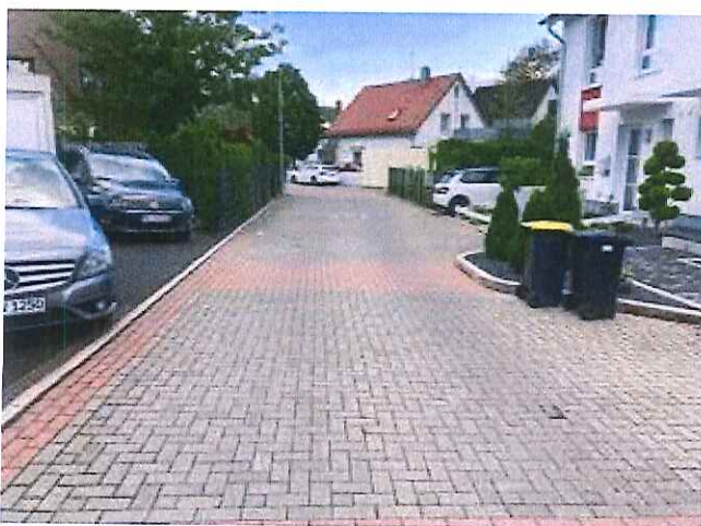
Bild 1: Buschhöfen, Richtung Bachstraße
