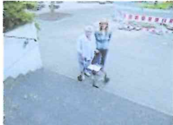
Edelgard Ebkemeier und Heike Menz vor der Treppe zum Haaner Hallenbad: Eine Rampe für Rollstühle, Rollatoren und Kinderwagen fehlt an der Sportstätte. HT-Foto: Heiko Richartz
