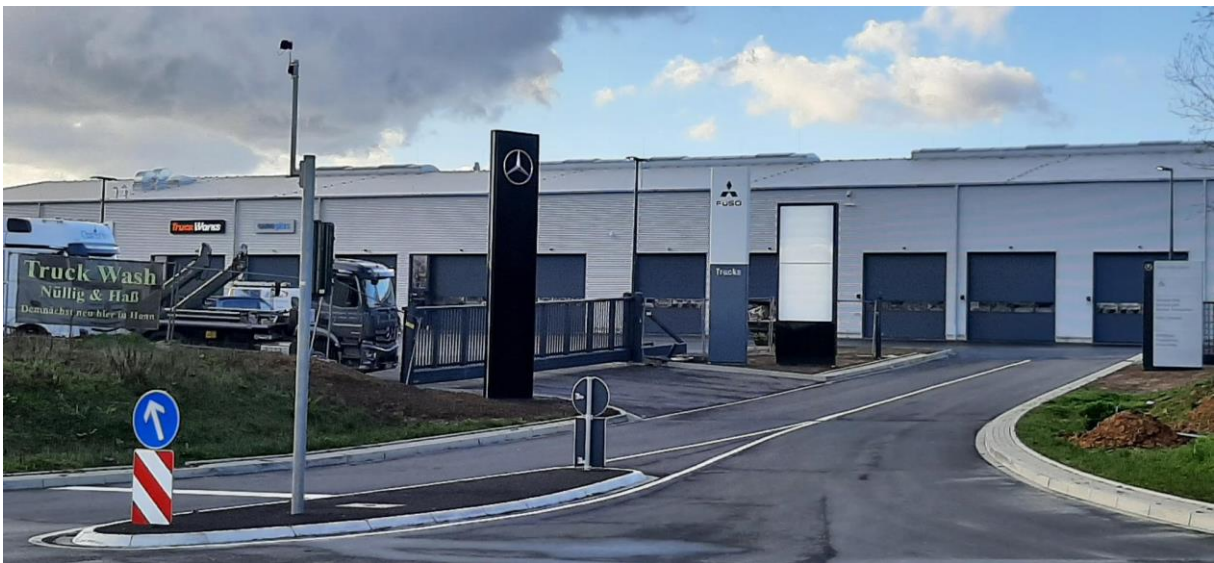
Bild 2: Gebäude der Firma Daimler Truck AG Nutzfahrzeugzentrum Mercedes-Benz, Haan
