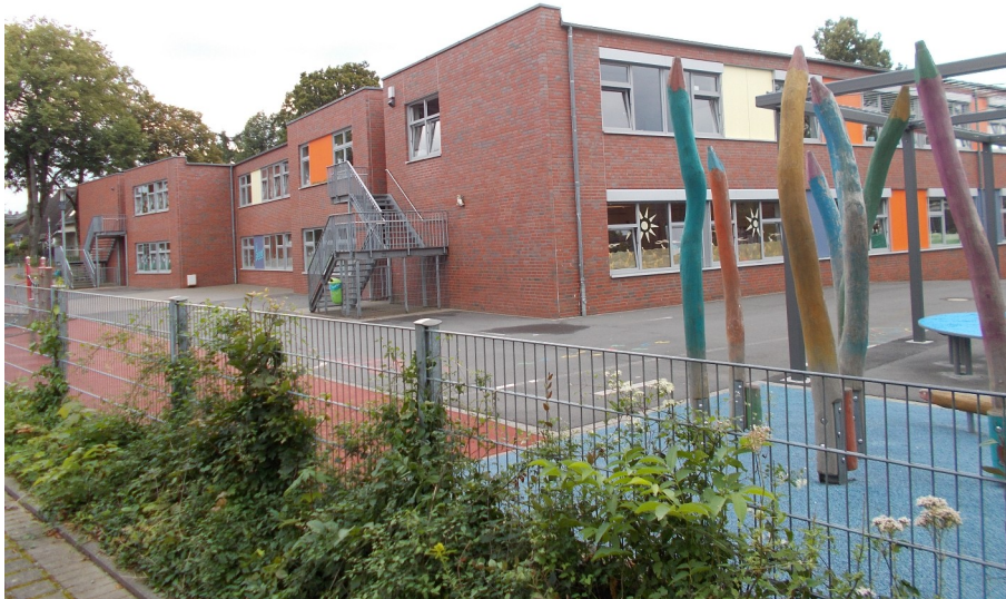
Abbildung 108: Außenansicht der GGS Mittelhaan 92
