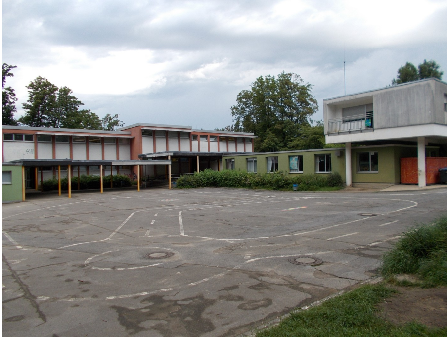
Abbildung 130: Außenansicht der GGS Unterhaan 109
