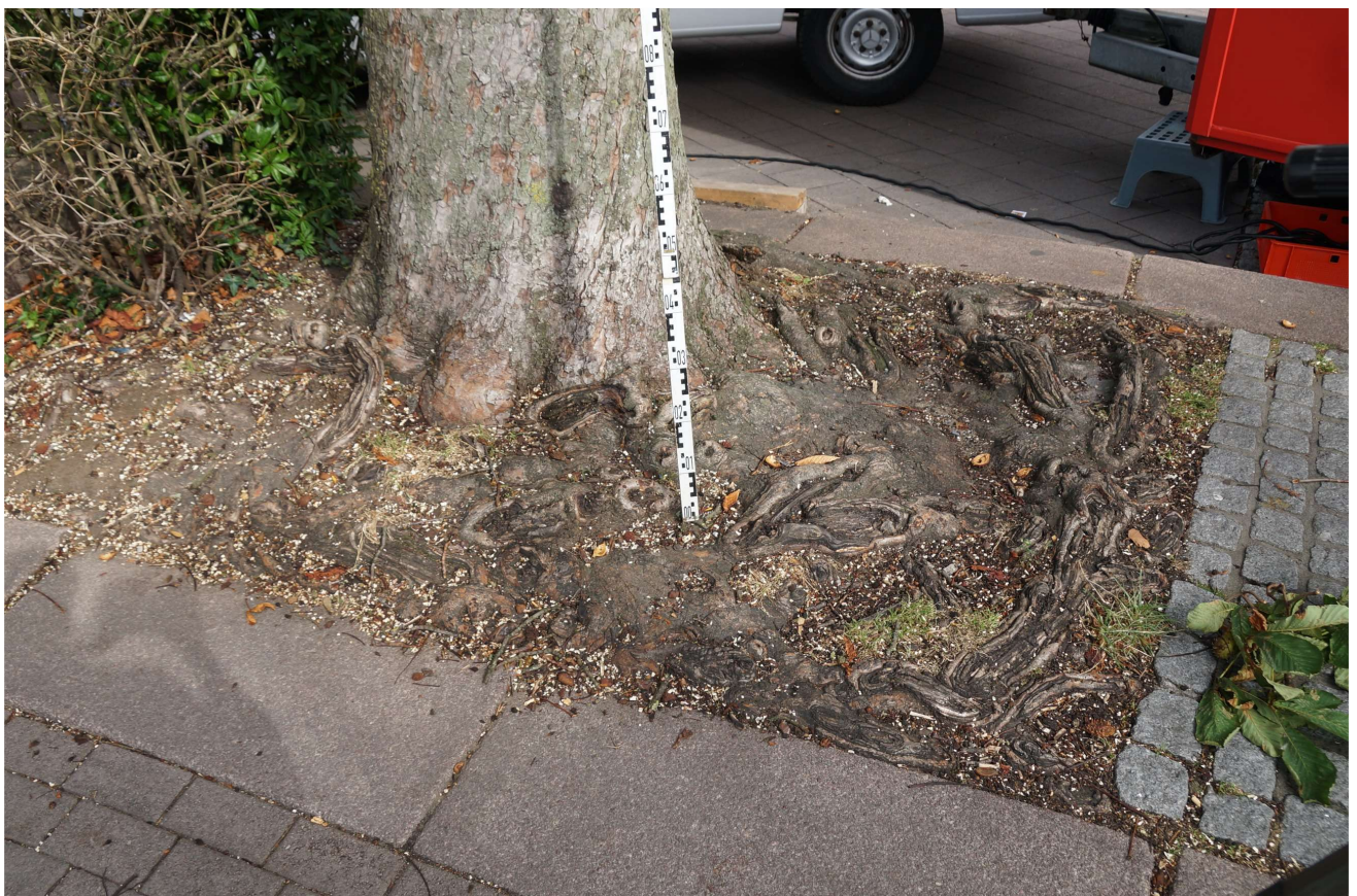
Foto 13: oberflächennahe Wurzeln mit erheblichen Schäden deuten auf einen unzureichenden Baumstandort hin, Wurzelraum nicht ausreichend
