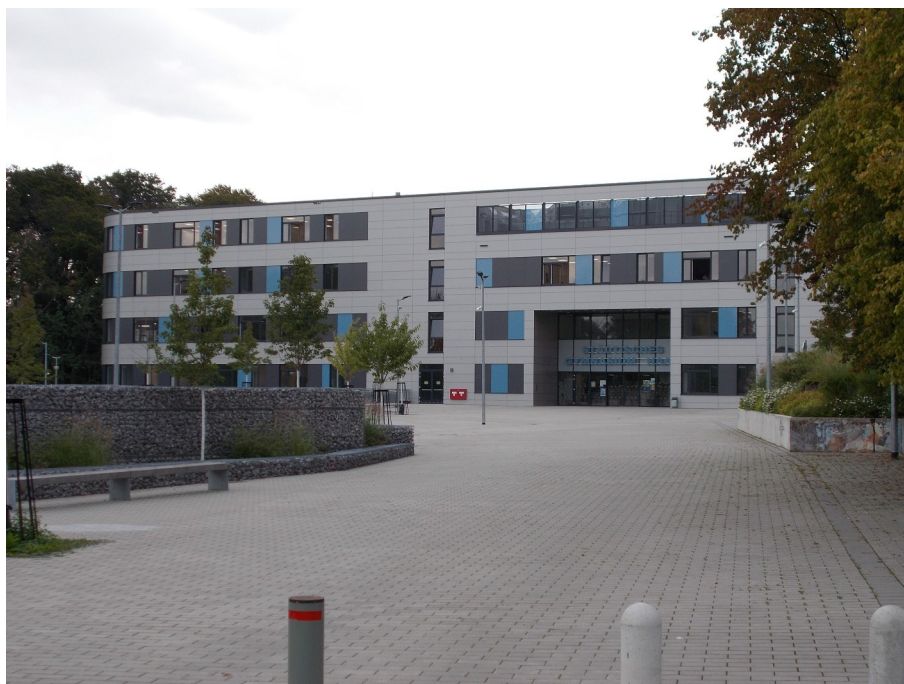
Abbildung 159: Außenansicht der GYM Haan 131
