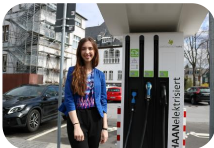
Vertragsschließung zur Ladesäule am Rathausparkplatz
