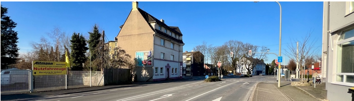
Abbildung 17 – Foto Gebäude Düsseldorfer Straße 63-65 / Am Schlagbaum 2 (Mischgebiet)
