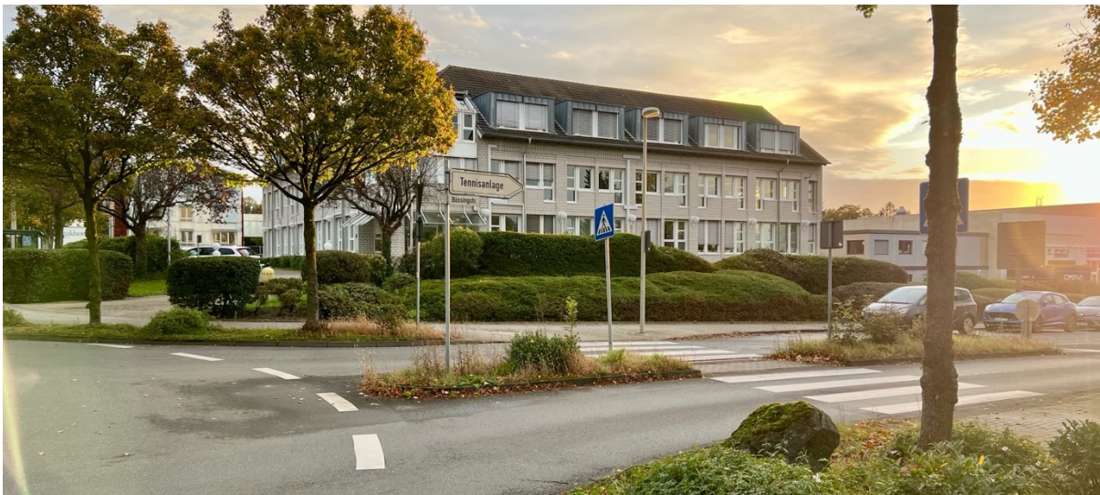
Abbildung 10 – Bürogebäude Fa. Donaldson, Büssingstraße 1-3
