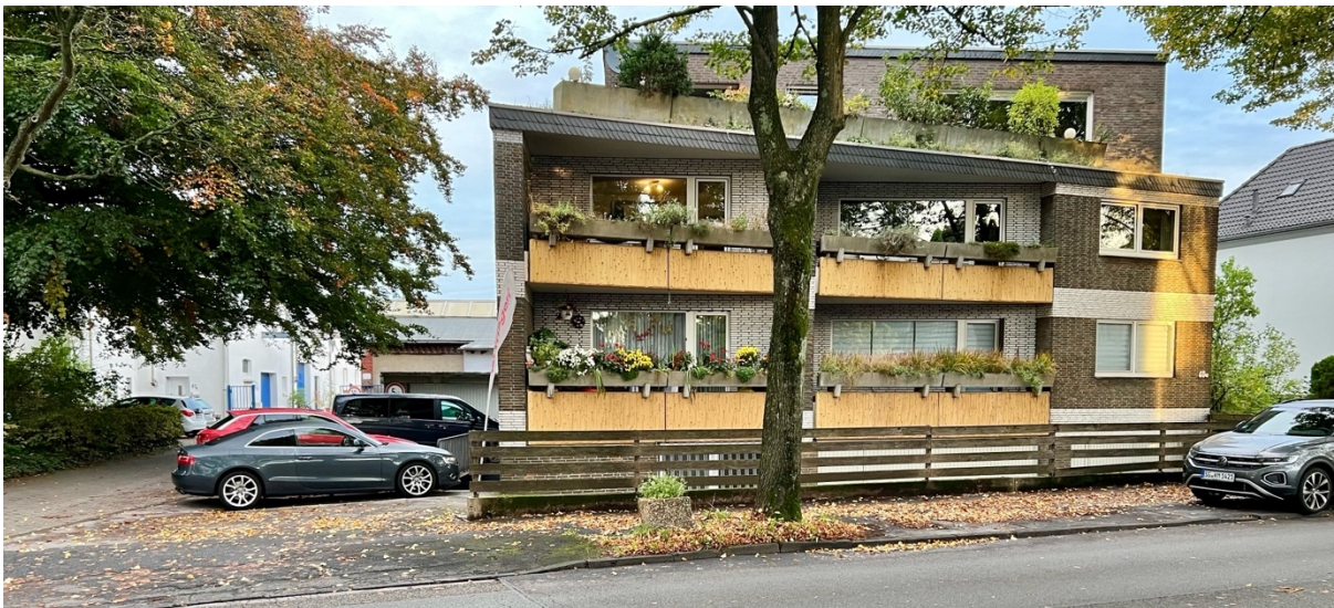
Abbildung 8 – Wohngebäude Wohngebäude Ohligser Straße 60a
