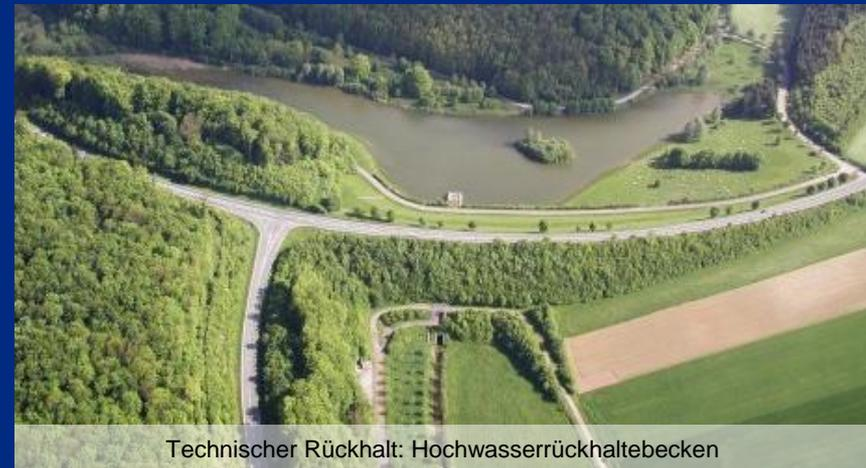
Technischer Rückhalt: Hochwasserrückhaltebecken
