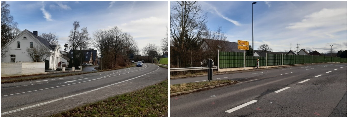
Abbildung 4: L 423 im Stadtteil Gruiten (Pastor-Vömel-Straße) (links: Wohnbebauung mit schalldämmender Bepflanzung, rechts: Wohnbebauung mit Lärmschutzwänden im Bereich Pastor-Vömel-Straße / Vohwinkeler Str.)
