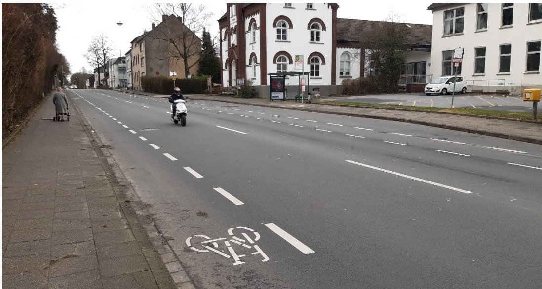
Abbildung 15: Beidseitige Schutzstreifen für den Radverkehr in der Alleestraße
