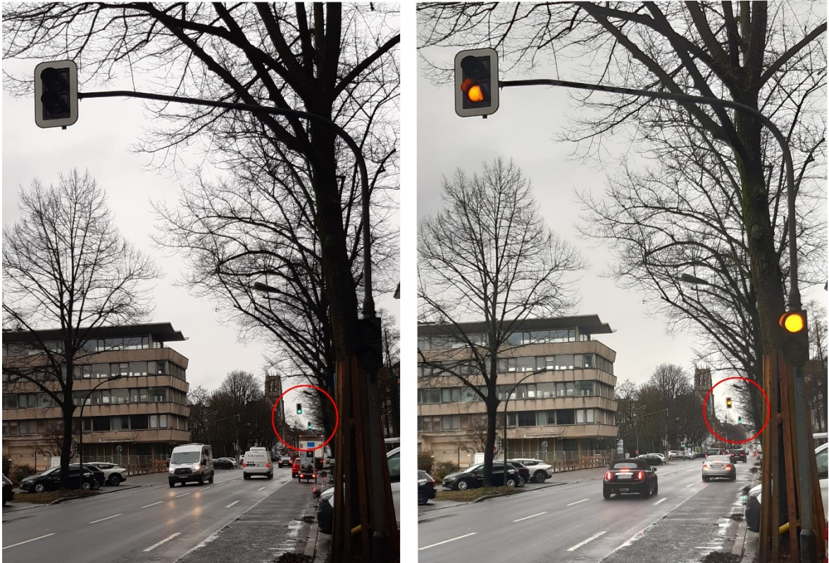
Abbildung 33: Vorsignalisierung zur Lichtsignalanlage (LSA) – Symbolbild Bild links: Vorsignal aus, die nächste LSA wird mit der Grünphase erreicht Bild rechts: Vorsignal gelbes Blinklicht, an der nächsten LSA ist „Halt“ zu erwarten.
