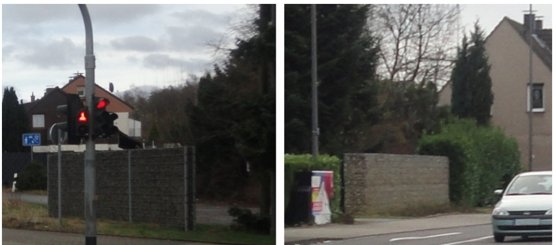
Abbildung 20: Gabionen an der Elberfelder Straße (B 228)
