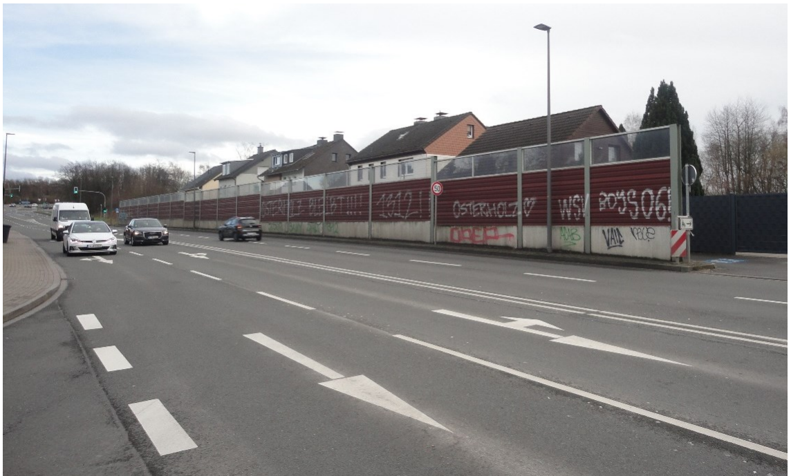
Abbildung 19: Schallschutzwand an der Gräfrather Straße (L 357)
