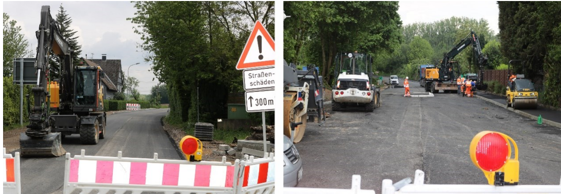
Abbildung 16: Sanierung der L 357 (Gruitener Straße) in Haan (Quelle: Stadt Haan)
