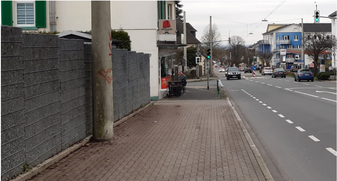
Abbildung 36: Kleine Lärmschutzwand (Gabione) im Stadtgebiet, Düsseldorfer Straße
