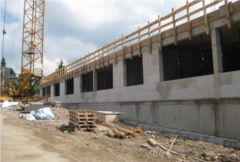
Foto der Baustelle vom 03.08.2010
