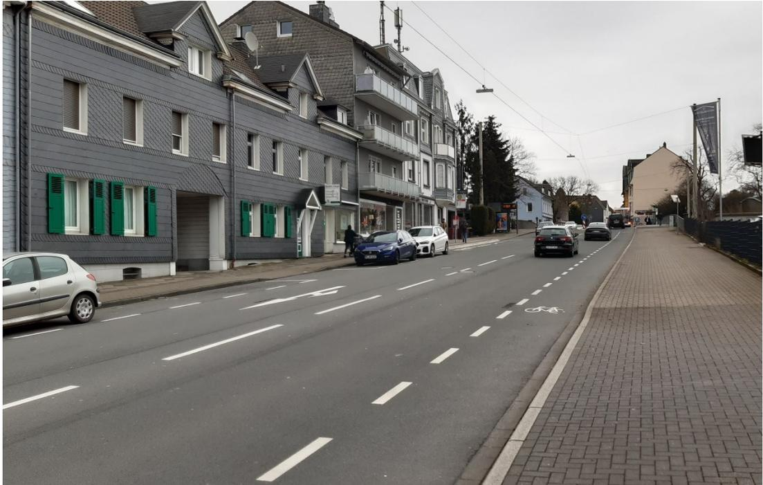
Abbildung 14: Schutzstreifen für den Radverkehr auf der „Bergauf“-Seite der Bahnhofsstr.
