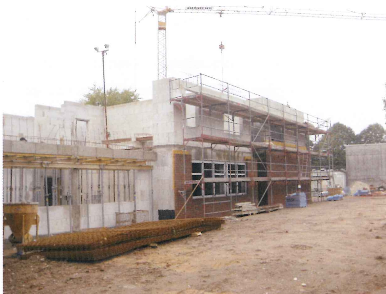
Foto der Baustelle vom 18.10.2010
