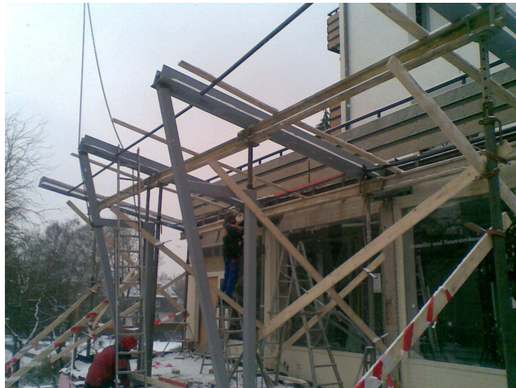
Stahlkonstruktion des Anbaus
