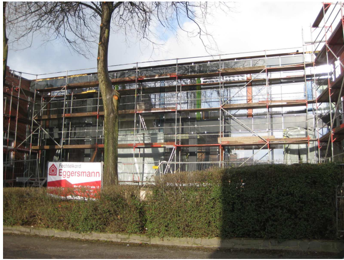
Foto der Baustelle vom 18.01.2011 (Haupteingang)
